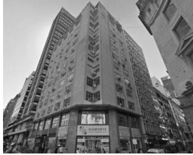
Fachada actual del edificio Martens en Buenos Aires.
